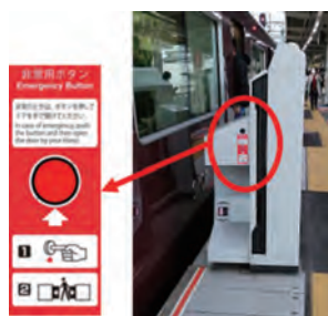
可動式ホーム柵非常用ボタン
