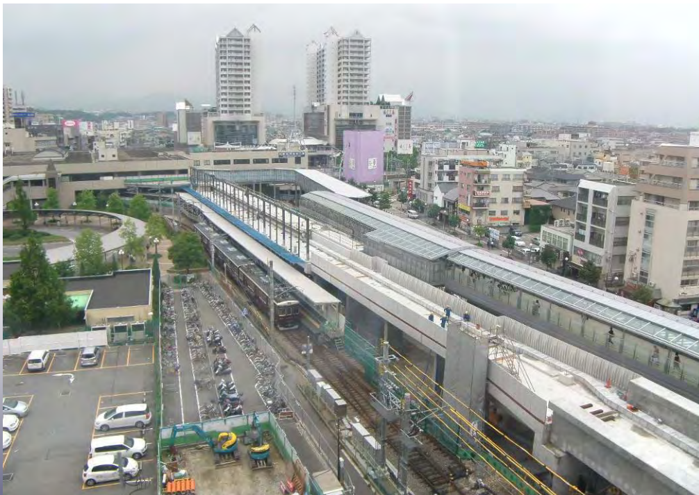
今津南線 高架化工事
