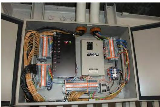
転落支障検知装置は、曲線ホームで列車との隙間が20cm以上の箇所に設置しています。この装置は、軌道内への転落事故が発生した際、軌道内の転落マットが検知し、アクシデントサインの点滅およびブザーの鳴動により、ホームに停車している列車の乗務員および駅係員に対し、転落事故の発生を知らせます。これまで転落マットの接続ケーブルが断線した場合は、次の検査まで発見できませんでしたが、転落マットを2枚1線で並列に動作させるように変更し、不用となった空き回線を活用して、断線検知回路を新たに構成し、ケーブルの断線を自動的に検知し、警報により、発見できるように改良しました。
