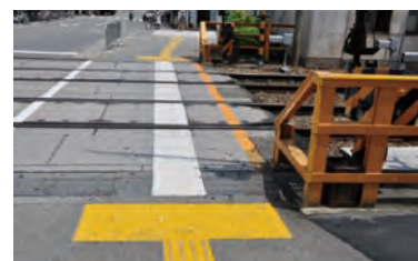
(踏切道に初めて設置した点字ブロック: 服部踏切道)
