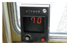
3 運転台ATS表示器
