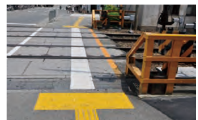
(踏切道に初めて設置した点字ブロック: 服部踏切道)
