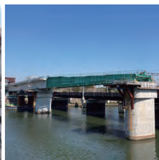
新神崎川橋梁架設工事
