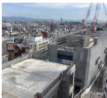
新淡路駅部工事
