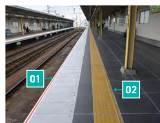
01 CPライン 02 内方線付点状ブロック
