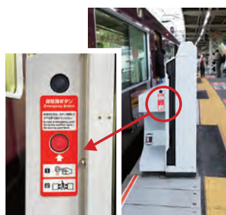
ホームドア非常用ボタン
