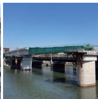
新神崎川橋梁架設工事
