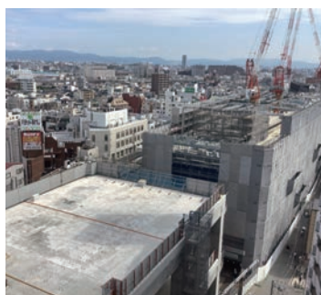
新淡路駅部工事
