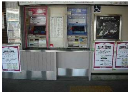
(上り線側)券売機改修
