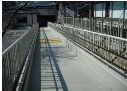
1号降車ホーム側スロープ新設、 2段手摺
