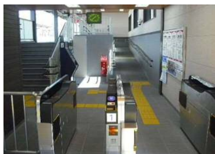
(上り線側) 改札口、改札機、スロープ新設
