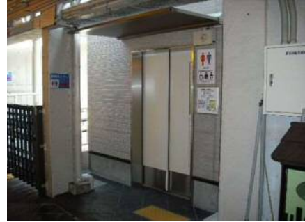
多機能トイレ新設
