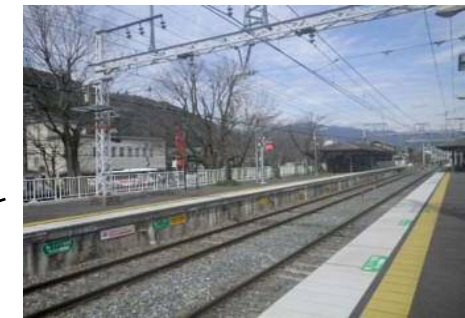
ホームかさ上げ新設
