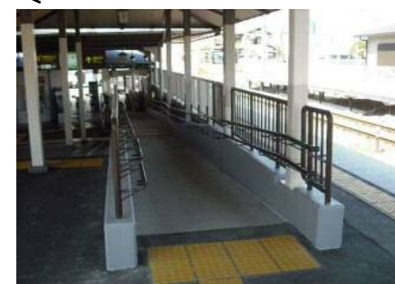
(上り線側)スロープ改良、2段手摺
