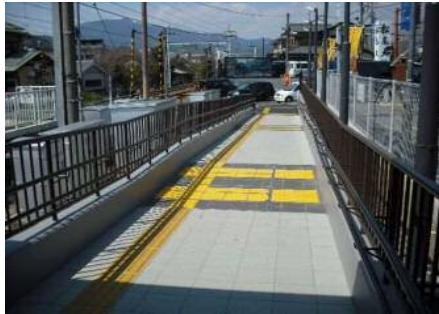
(下り線側)スロープ、通路新設
