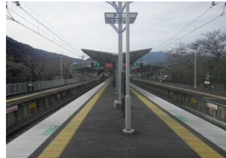
1・2号乗降ホームかさ上げ新設
