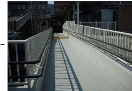
2号降車ホーム側スロープ新設、2段手摺
