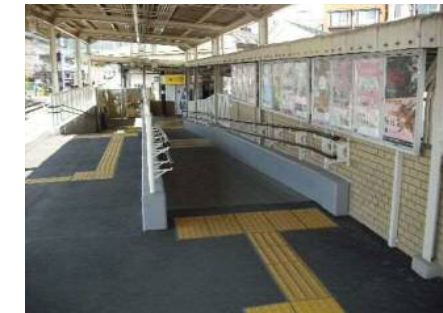
(下り線側) スロープ改良、2段手摺
