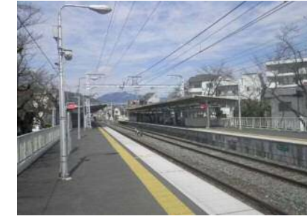
ホームかさ上げ新設
