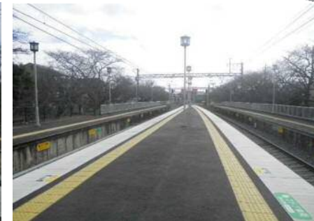
1・2号乗降ホームかさ上げ新設
