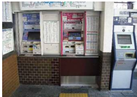
(下り線改札) 券売機改修
