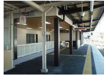
(上り線側) 改札口、上屋新設
