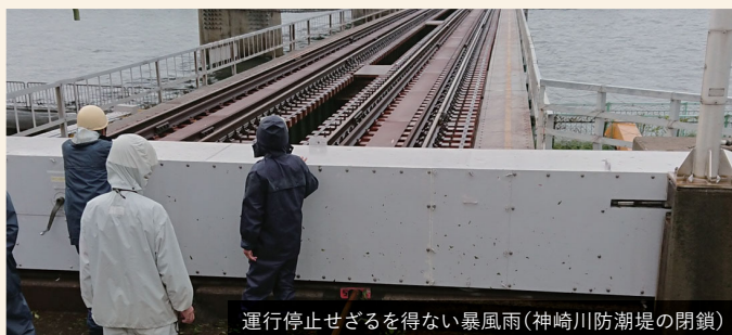
運行停止せざるを得ない暴風雨(神崎川防潮堤の閉鎖)
