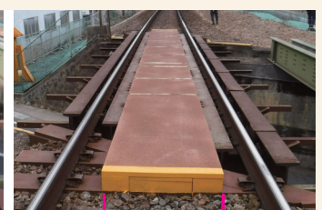
拡幅後の歩み板
