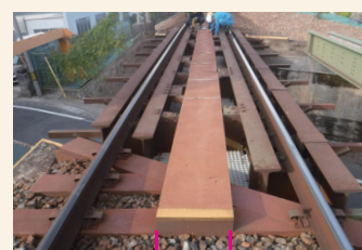
拡幅前の歩み板
