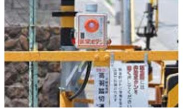
踏切未降下検知装置は、トラブル等で遮断桿が完全に降下しない場合にそのことを検知して運転士に知らせるもので、踏切非常通報装置と同様に、踏切直近の信号機を赤(停止)にし、運転士に異常を知らせるとともに、ATS(自動列車停止装置)ブレーキが自動的に動作します。
