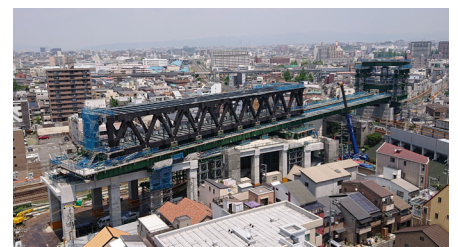
トラス桁架設工事
