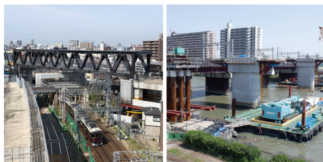
トラス桁架設工事
