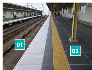
01 CPライン 02 内方線付点状ブロック
