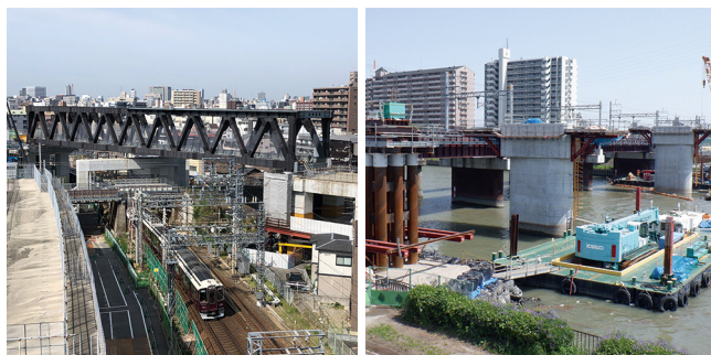
トラス桁架設工事
