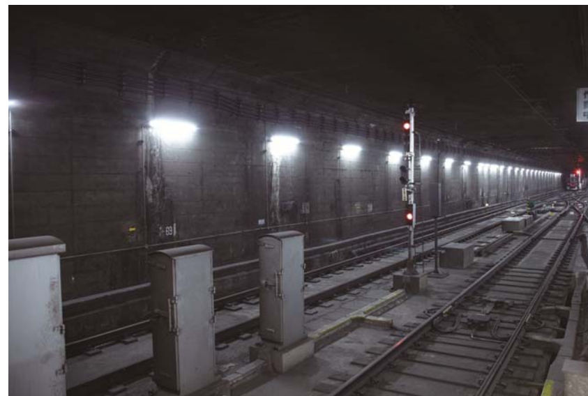
【環境省委託事業】京都地下トンネル（LED照明）
