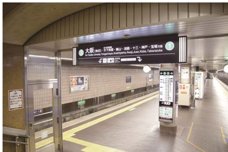
【環境省委託事業】電照看板（LED照明）
