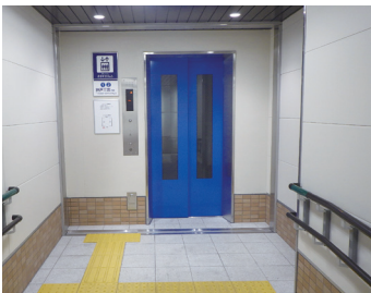
2階(構内)エレベーター
