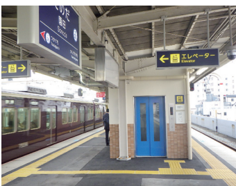
3階(ホーム上)エレベーター
