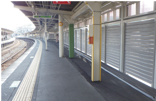
ホーム拡幅状況(北千里行きホームの北千里方)
