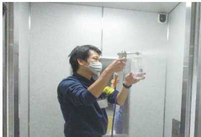
エレベーター内 抗ウイルス・抗菌加工の様子
