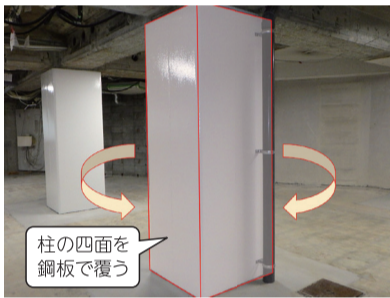
鋼板巻き立て工法(イメージ)
