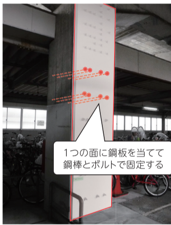
一面補強工法(イメージ)
