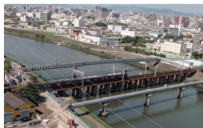
2010年10月 工事着手前
