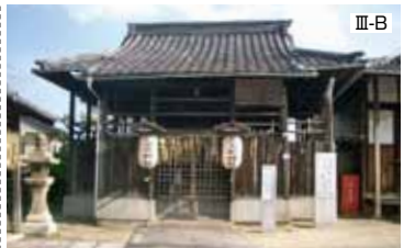
1 関大明神社 平安時代に西下する貴族や官人がここで別れを惜んだ地。本殿は室町中期に造立され、大阪府指定文化財となっている。
