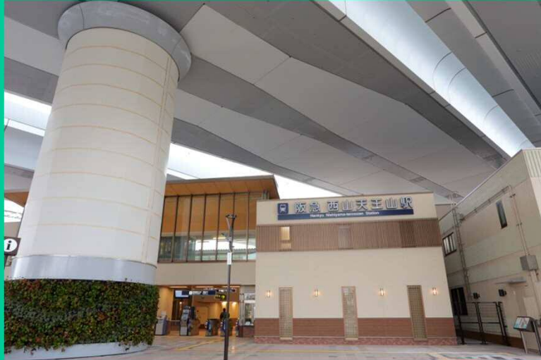
【京都縦貫自動車道との交差部に 西山天王山駅が誕生(写真は東口改札前)】
